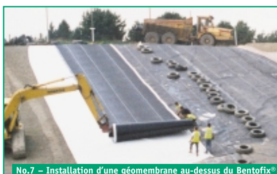
No.7 - Installation d'une géomembrane au-dessus du Bentofix®
